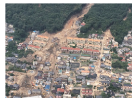
平成26年8月の広島市土砂災害
